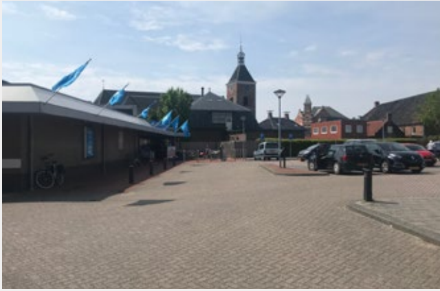
Huidige westgevel aan het parkeerplein
